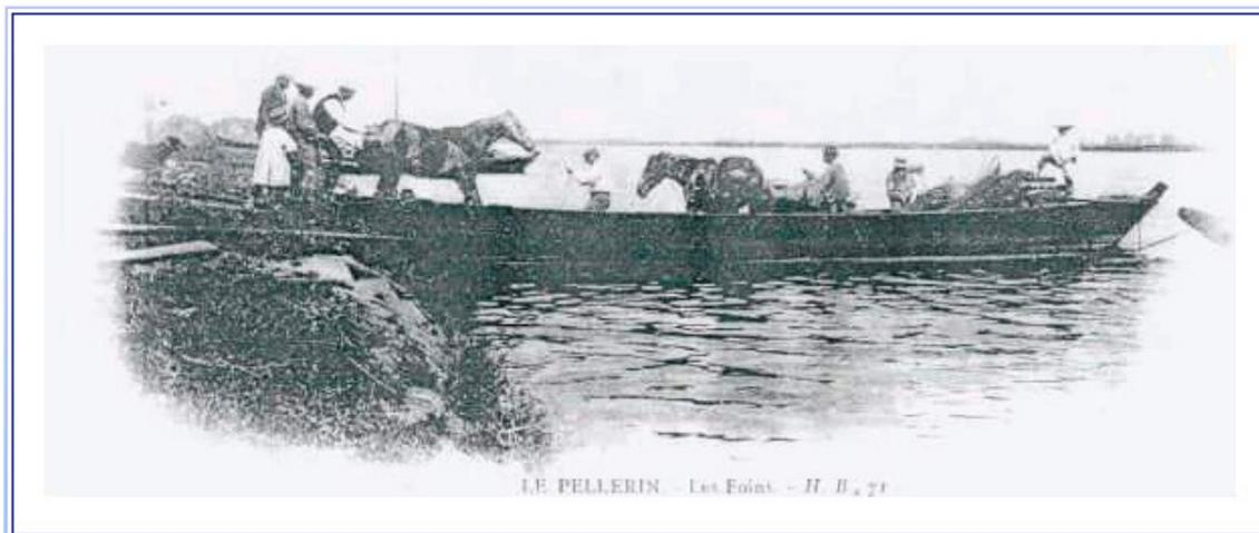
C'est une embarcation spécifique à la Loire et adaptée au manque d'eau en été (fond plat). Elle peut mesurer de 10 à 15m de long sur 3m de large et peser 3 tonnes.
