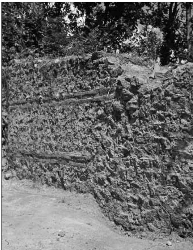
Figure 17 : Face interne du mur extérieur oriental montrant la réfection à arases de briques (phase IV) qui s'appuie sur le mur antérieur (phase III). Les joints tirés au fer entre les moellons de schiste sont bien visibles (Cl. J. Hyvert, 1979).
